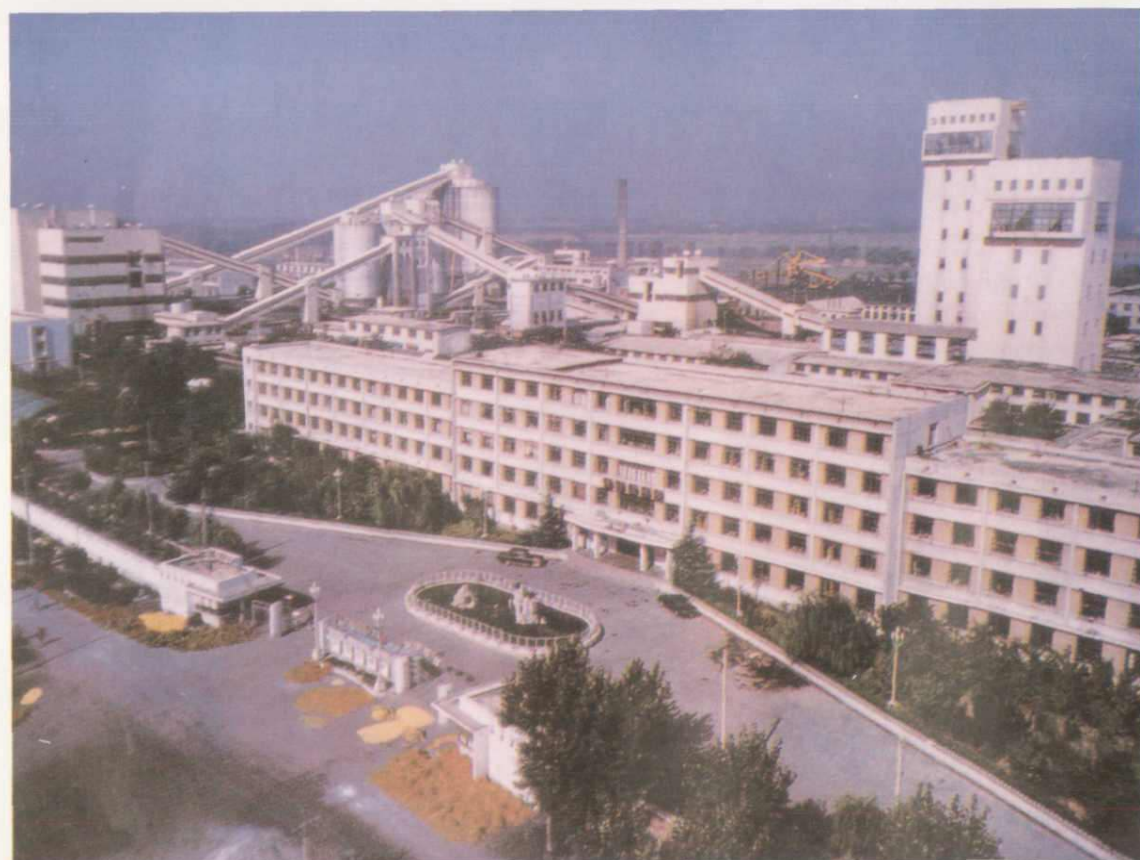
自行设计和施工的全国第一个年产 300 万吨的现代化矿井——兖州兴隆庄煤矿
