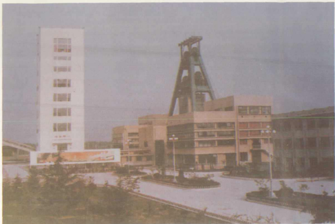
山东煤矿首先使用多绳轮落地提升机提升的年产 300 万吨的鲍店煤矿
