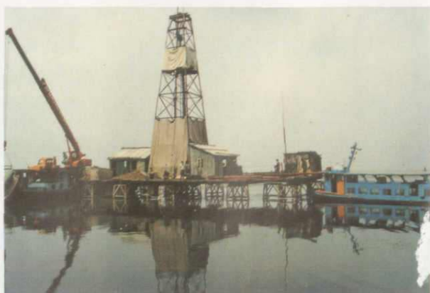
水上钻探平台正在南四湖上施工
