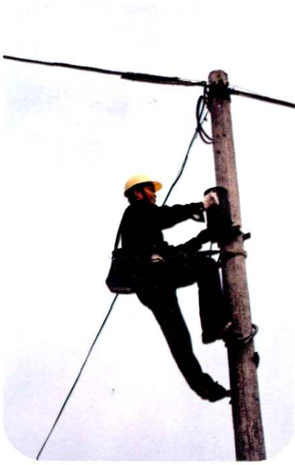
机线员在杆上作业
