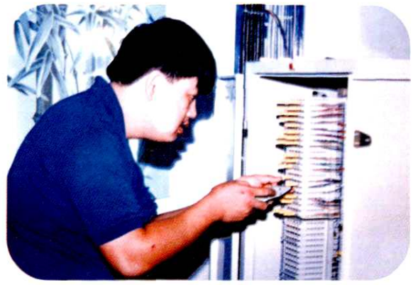
机务员在检修配线设备
