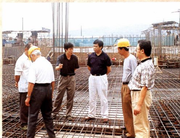
市局领导在新建办公楼检查施工质量
