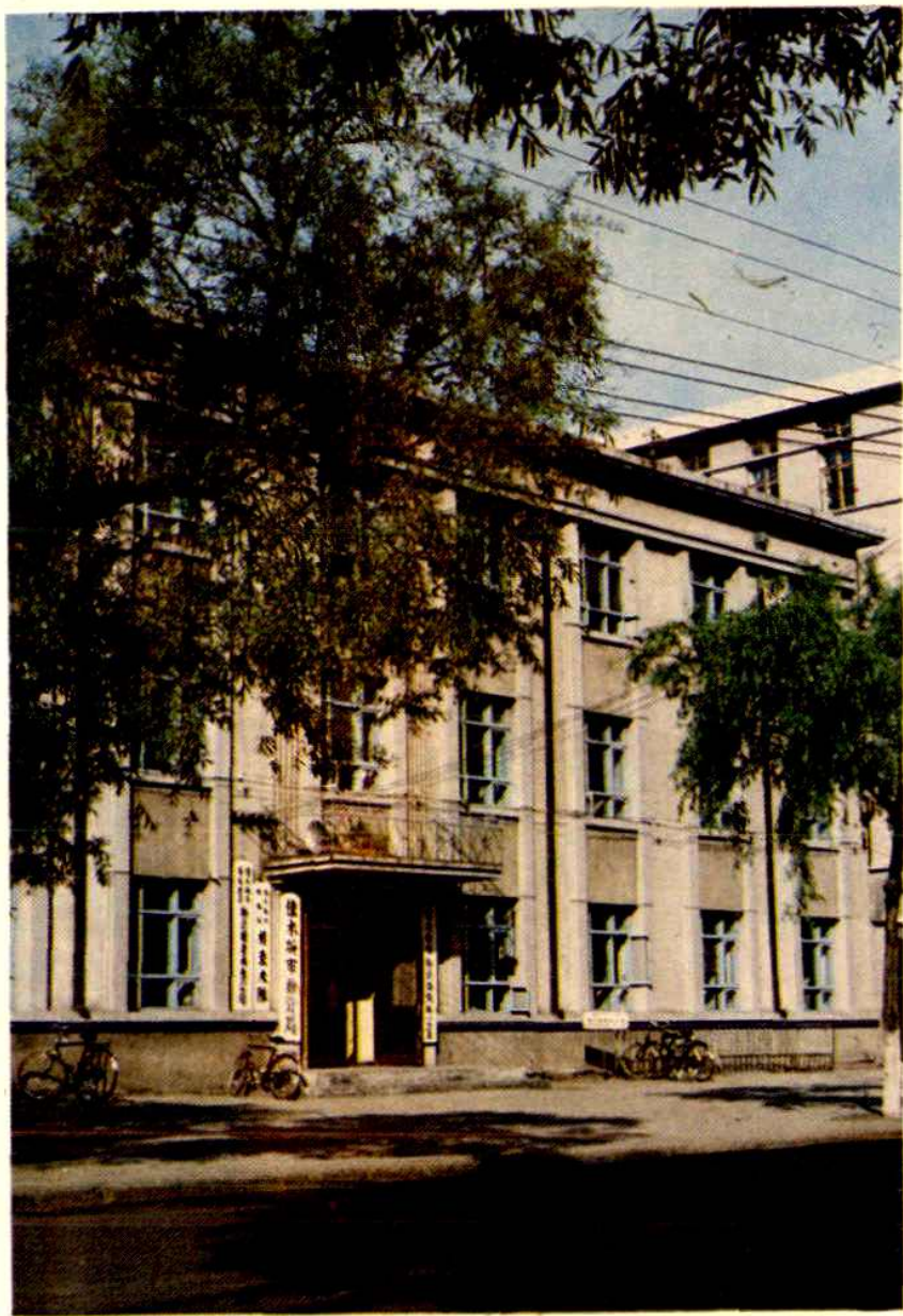
佳木斯市物资局办公楼 原合江行署物资局办公楼 地址
