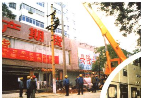
▲ 城网改造工程中新建路 10 千伏线路换线
