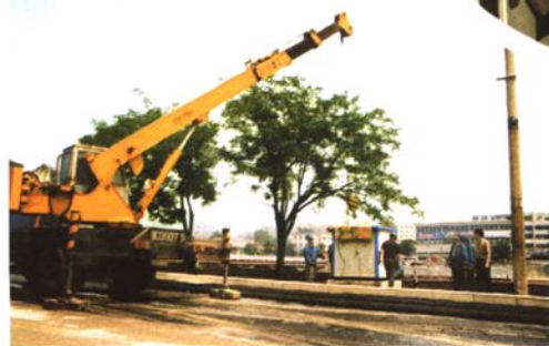
▲ 城网改造工程中安装箱变施工。
