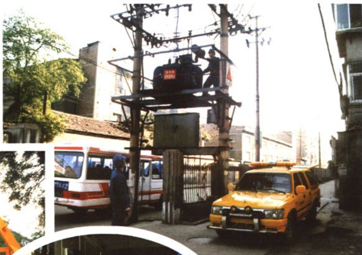
▶ 变电运行班人员在变台上作业。
