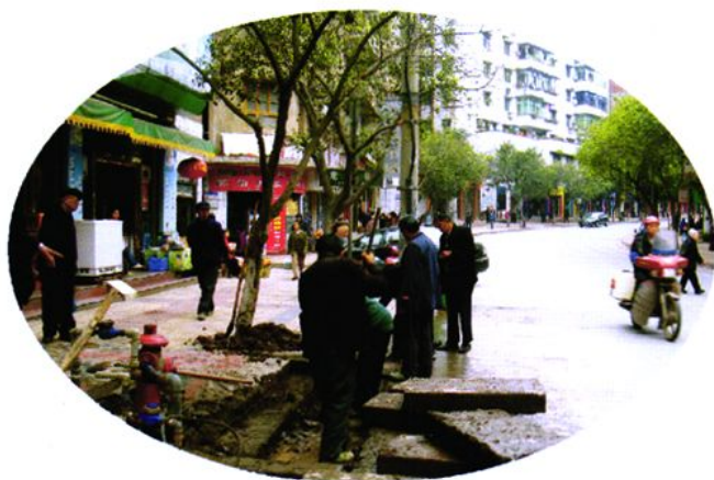
上东街下水道整修
