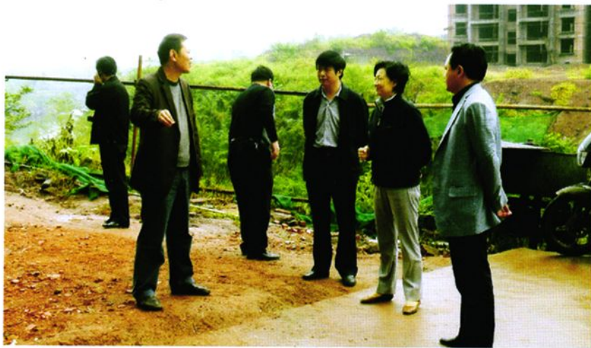
省住建厅党组成员、机关党委书记田利娅视察保障性住房建设现场
