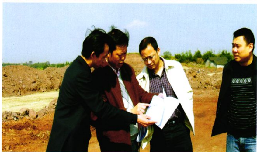
市民生办领导与县组织部苏怀纪部长视察廉租房建设现场
