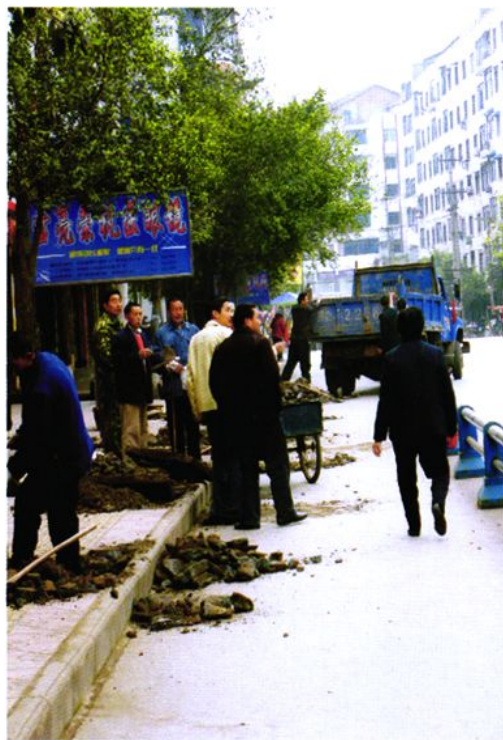
建设南路下水道清淤
