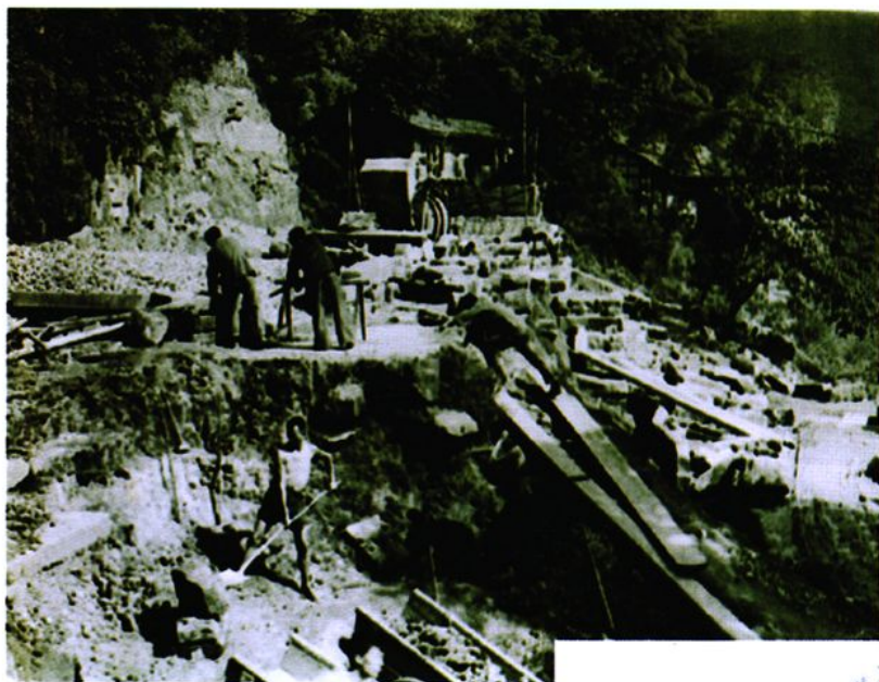
下河街改建工地
