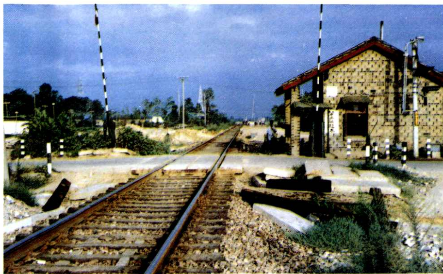
正在建设中的 宣长铁路立交桥段
