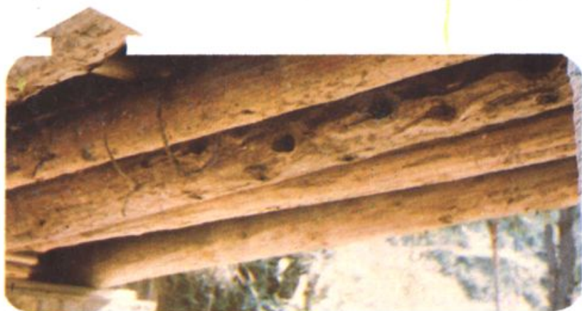
▶ 双翰广济桥底梁
