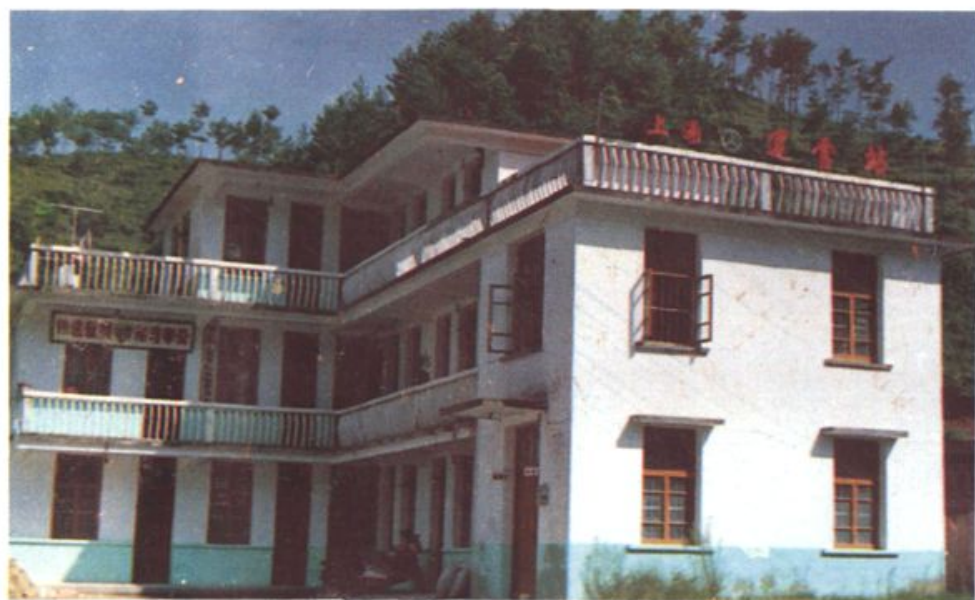
◀ 上涌运输管理站
