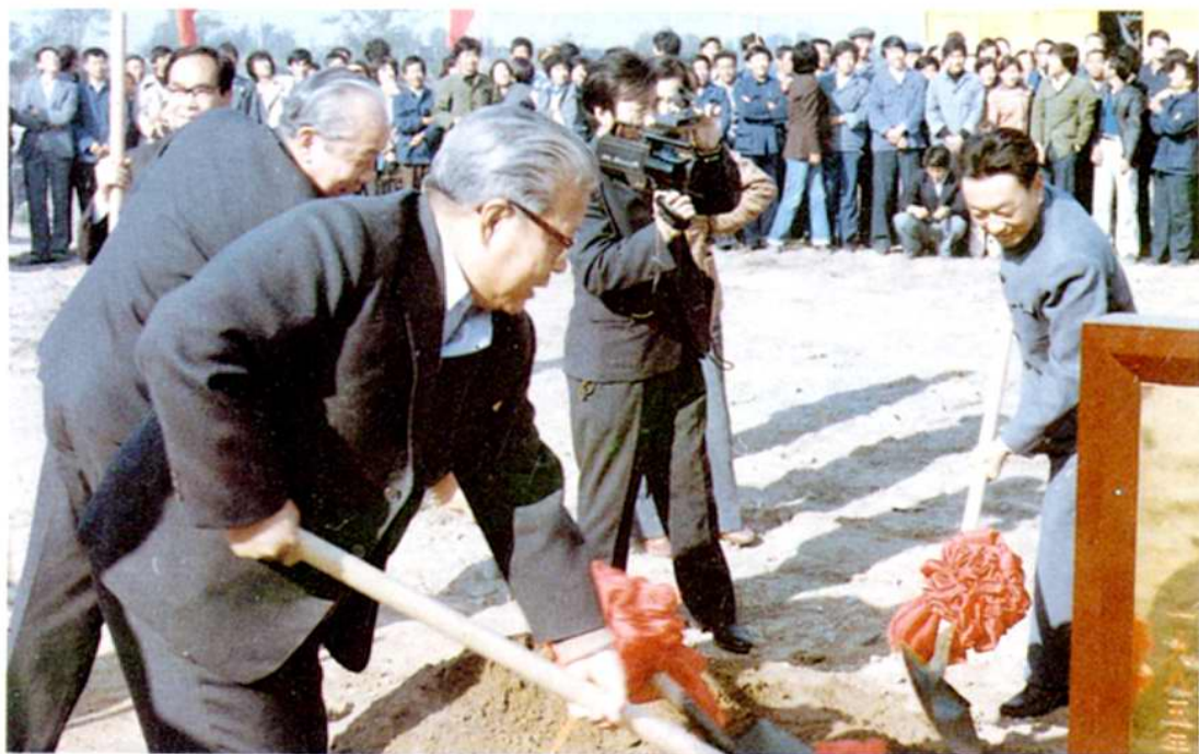
市委书记李锡铭、市长陈希同为石景山热电厂工程奠基
