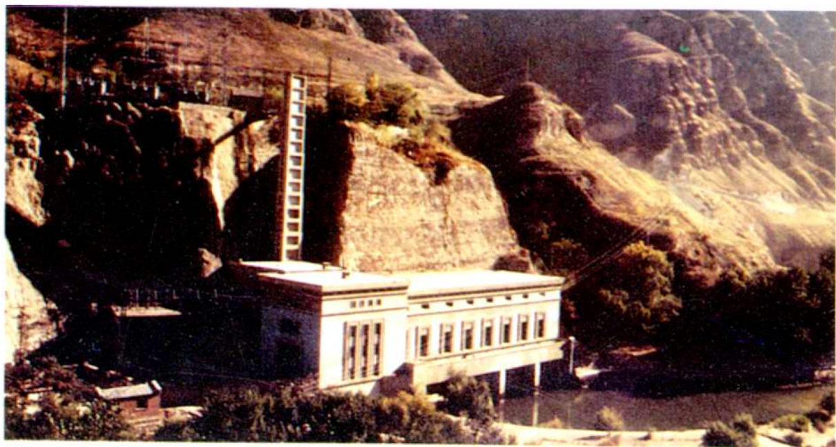
官厅水力发电站
