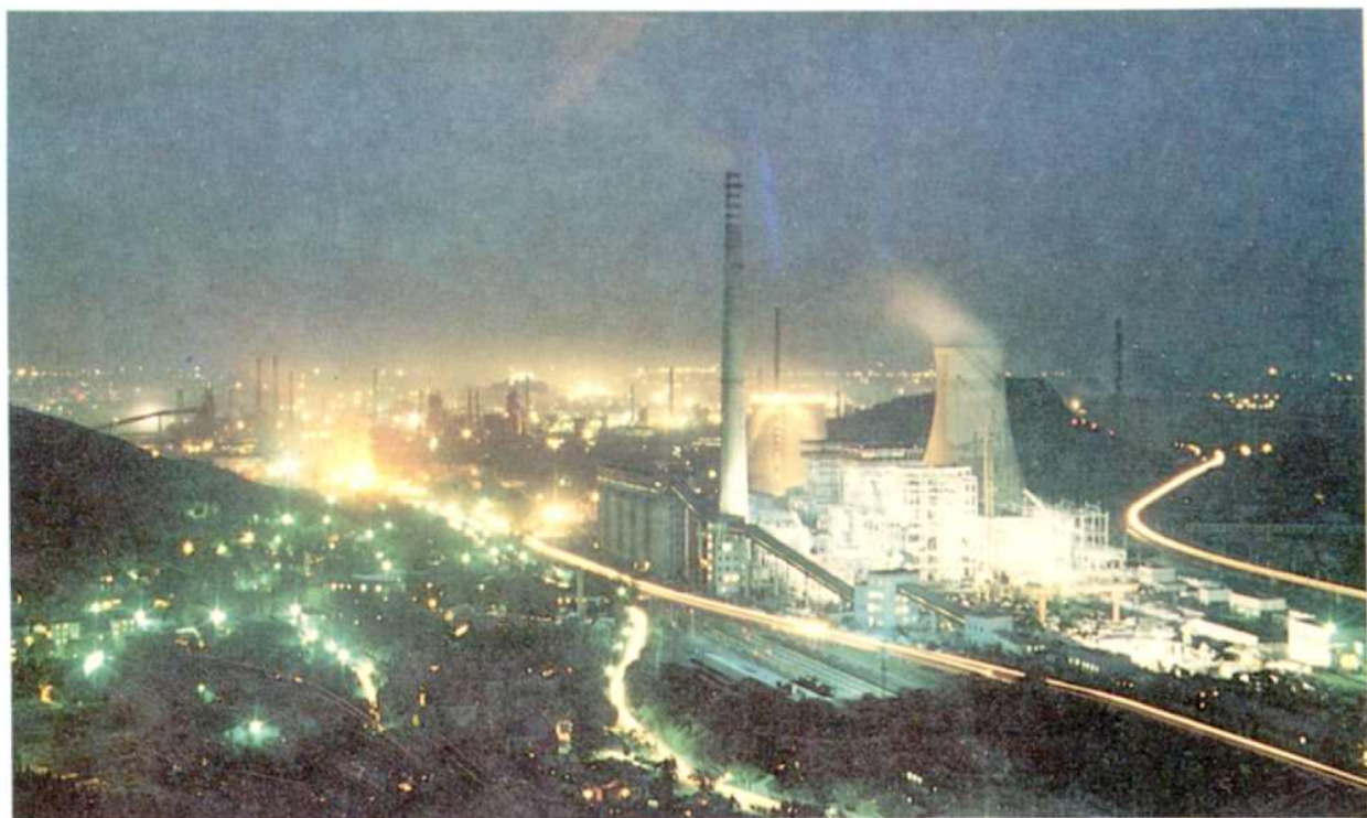
正在建设中的石景山热电厂
