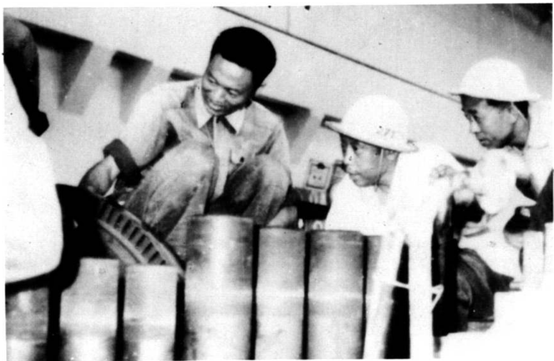
刘澜波部长在高井发电厂检修现场
