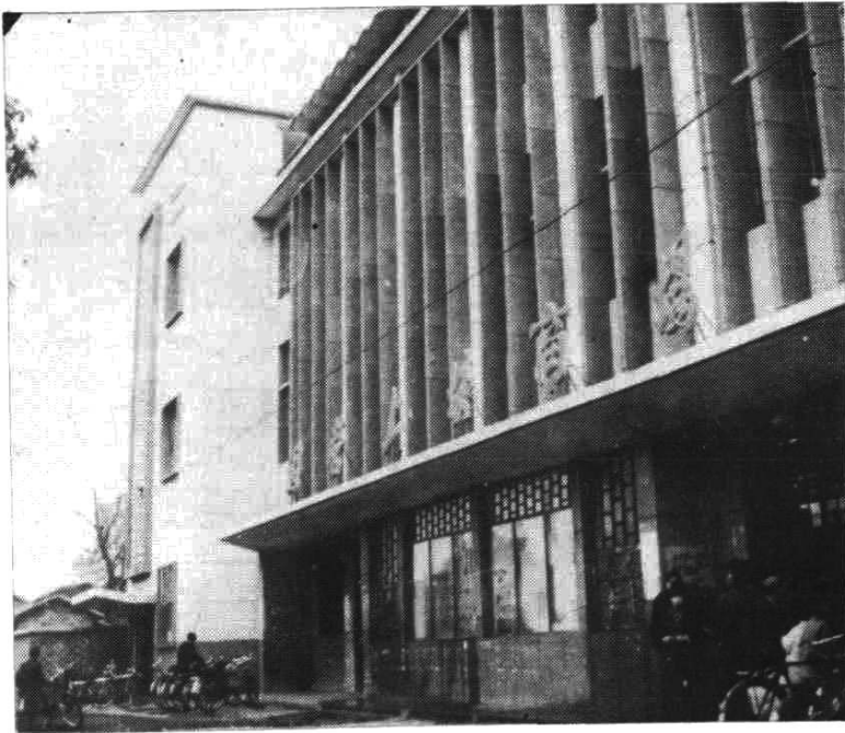
丰城矿贸上塘综合商场
