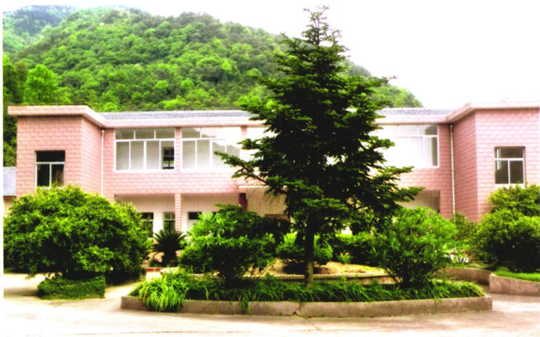
▲茶山林场场部办公楼
