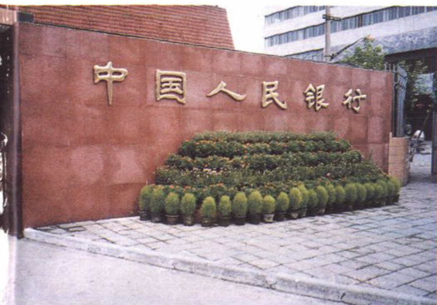
中国人民银行江阴市支行办公大楼
