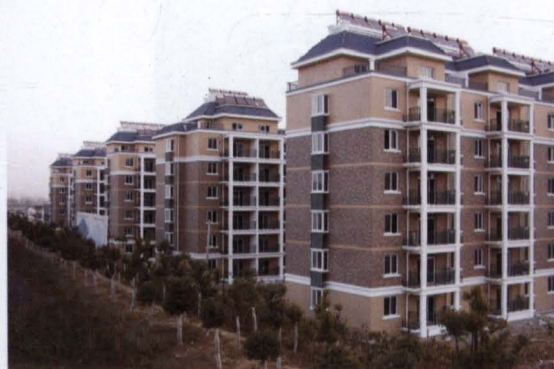
腰铺镇安置房
