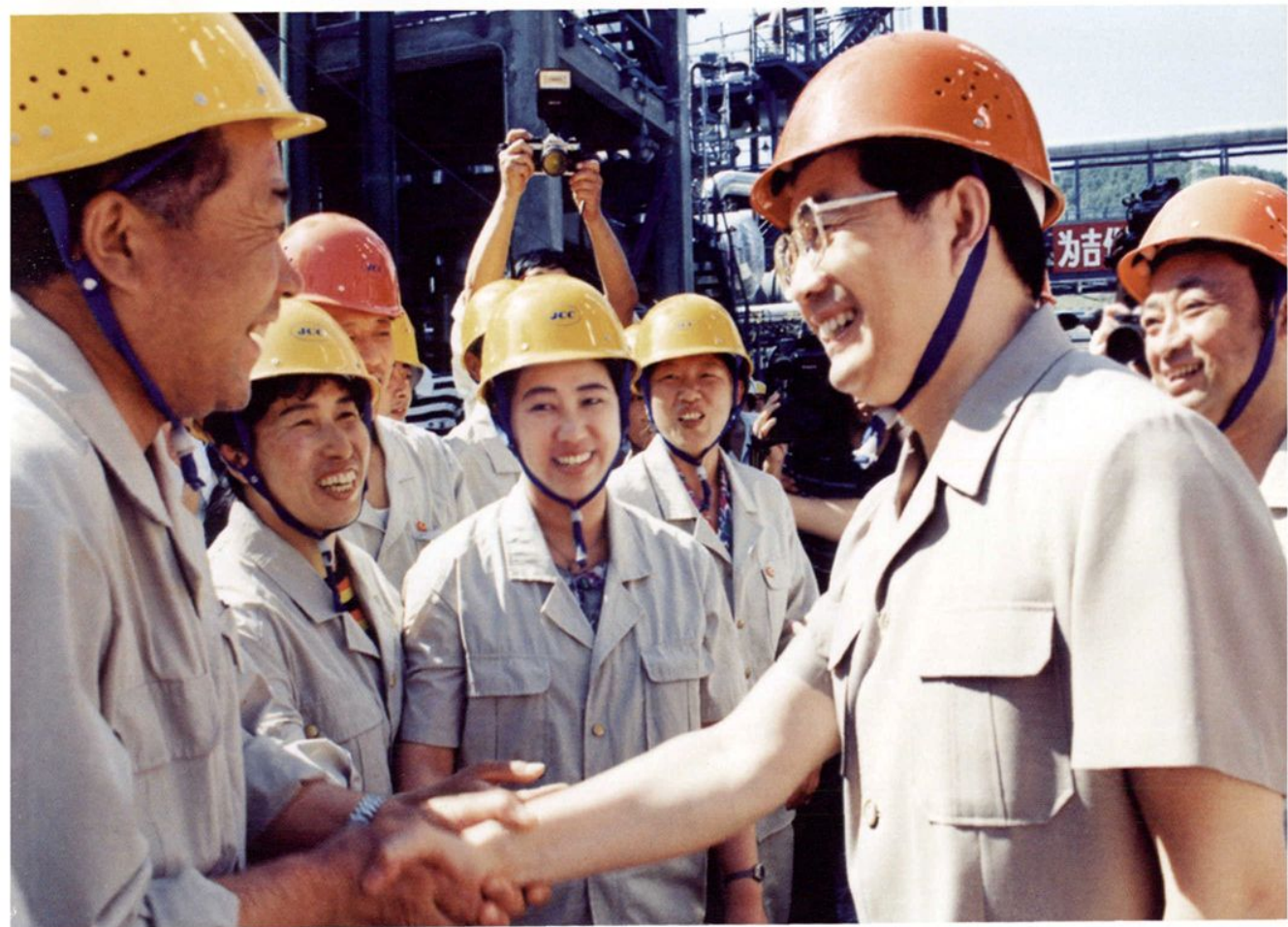
1996年6月22日，胡锦涛同志视察炼油厂乙烯分厂建设工地。
