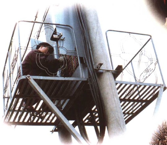
机线人员调测电话线路
