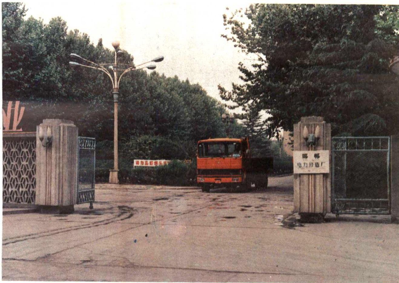
邯郸电力修造厂西大门
