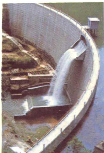
图 2 甲甸水库混凝土砌石
