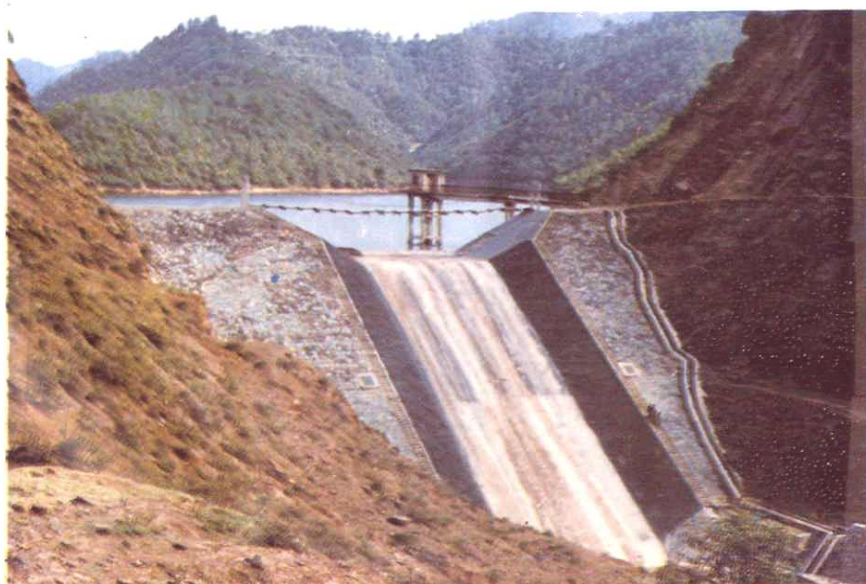
图 4 中型封过水库堰顶溢流干砌
