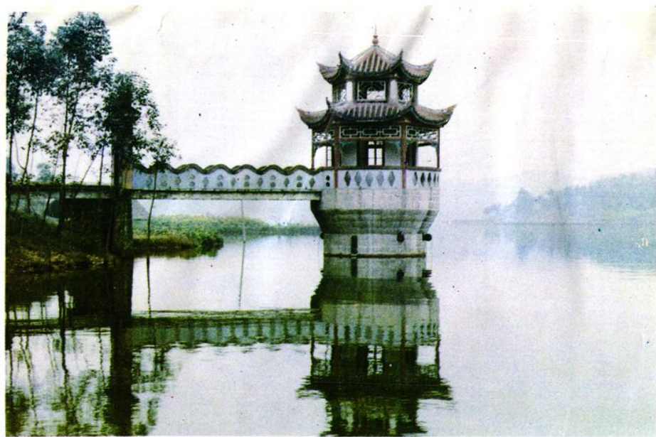
云官干渠取水口
