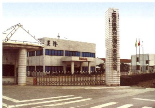
上海显隆惠利空调设备有限公司
