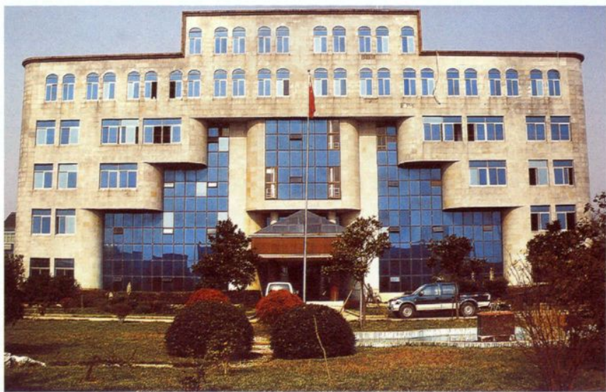
胡桥镇党委、政府办公大楼
