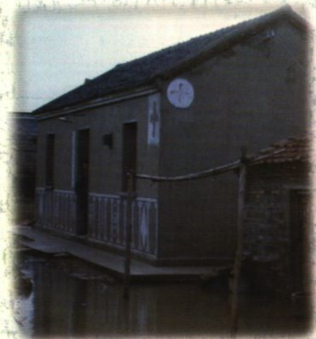
洪泽县老子山镇张嘴村 湖畔卫生室
