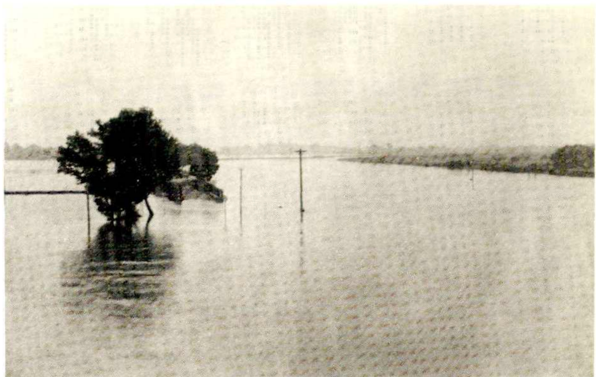
湖熟至土桥公路被淹，公路两旁一片汪洋 夏才葆 摄
