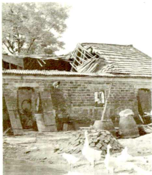
龙都乡村民住宅被暴雨冲塌 李常耕 摄
