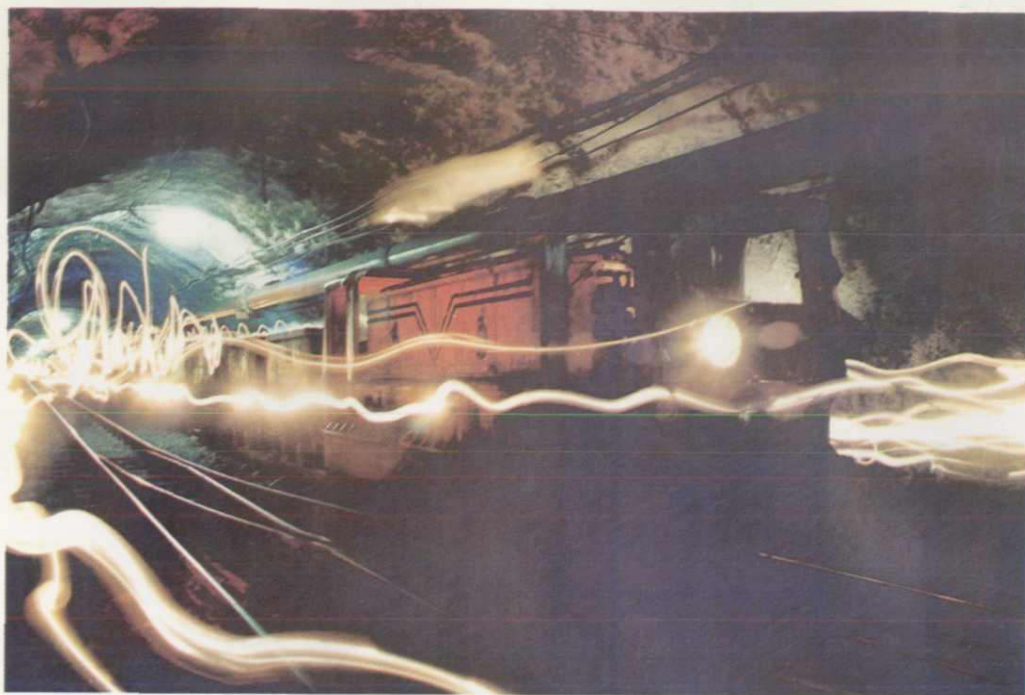
松藻矿务局矿井运输标准化巷道
