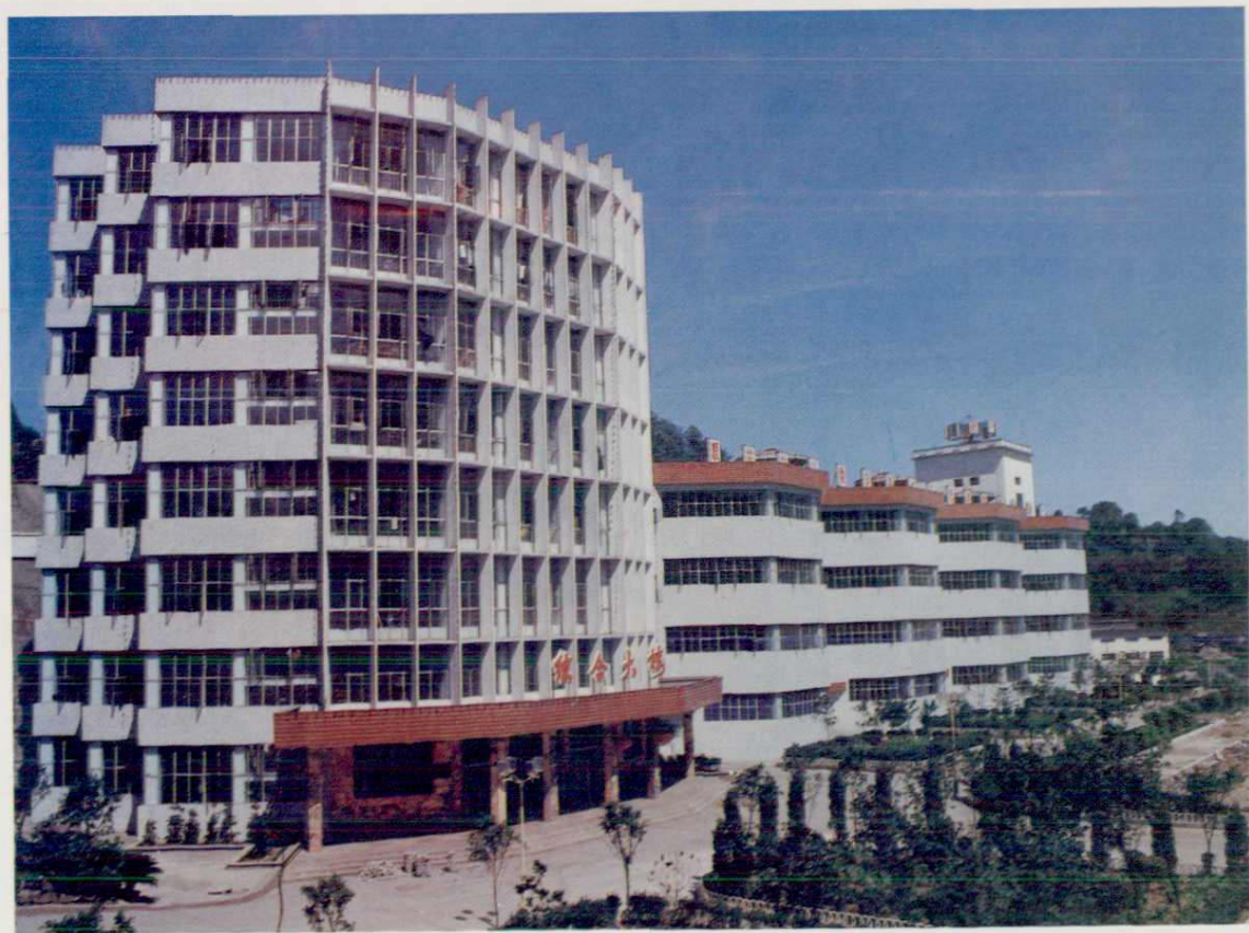
打通一矿综合大楼
