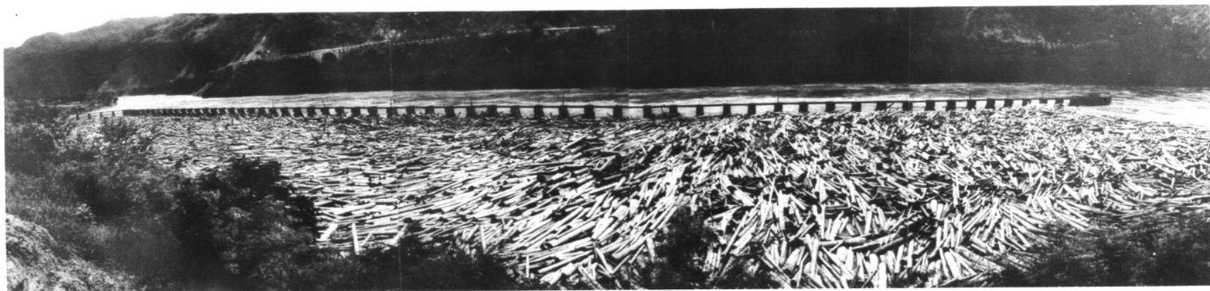
小得石贮木场米筛沱重力式钢筋混凝土木材收漂工程
