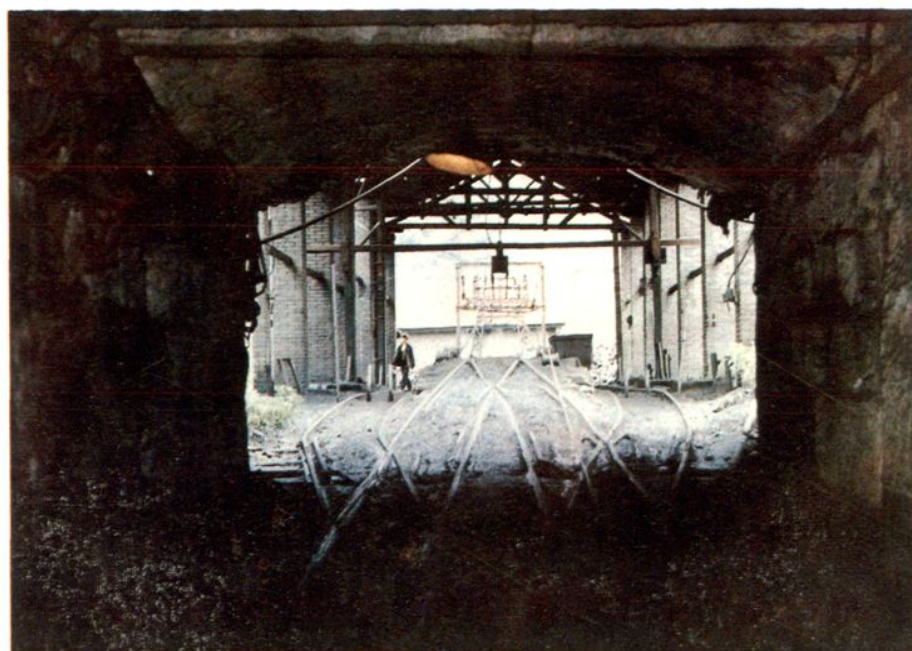
年生產能力15萬噸原煤的斜井井口
