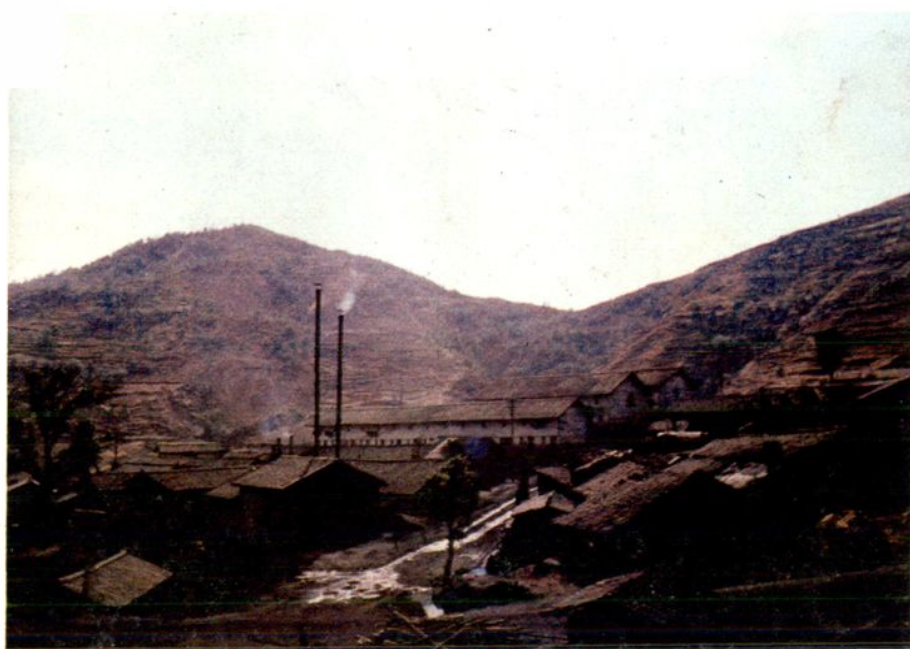
三矿区生活区
