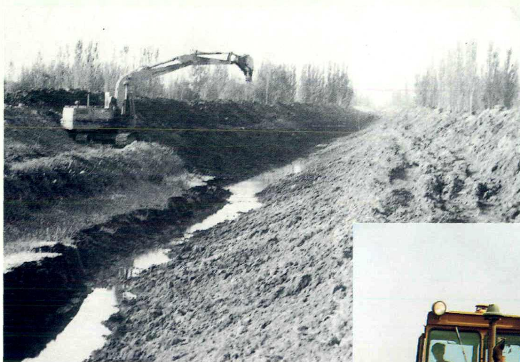
挖掘机在清挖排渠(1985年)
