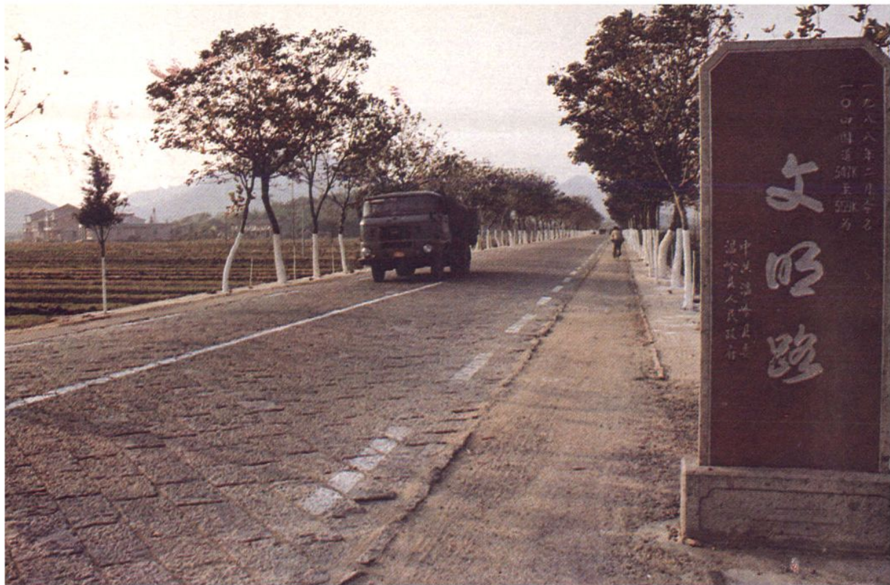
△ 温岭块石路面
