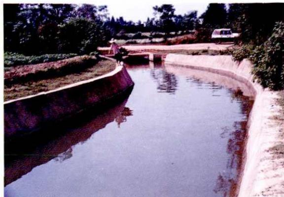
3730 项目工程之一——渠道硬化
