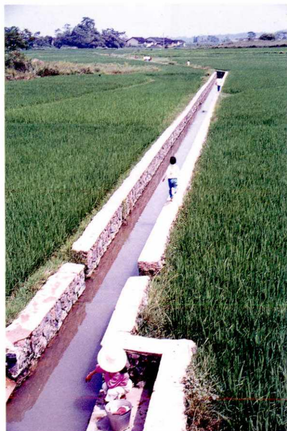
3730 项目工程之二——开沟治潜
