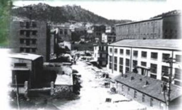
1985年工厂扩建施工
