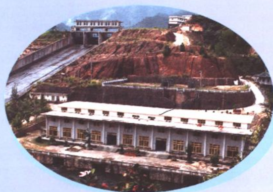
▲ 罗坑水库坝后电站
