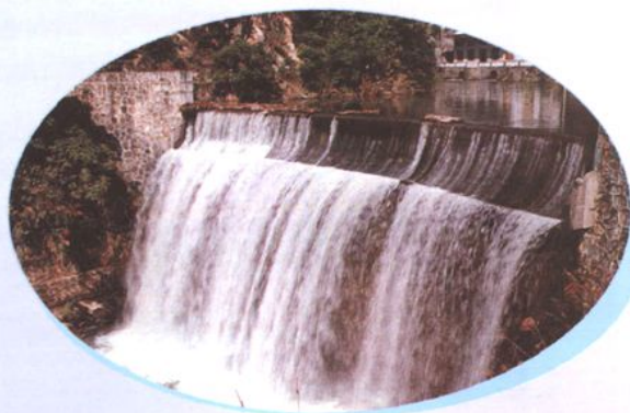
▲ 小坑峡水电站
