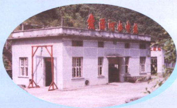
▲ 龙归续源水电站
