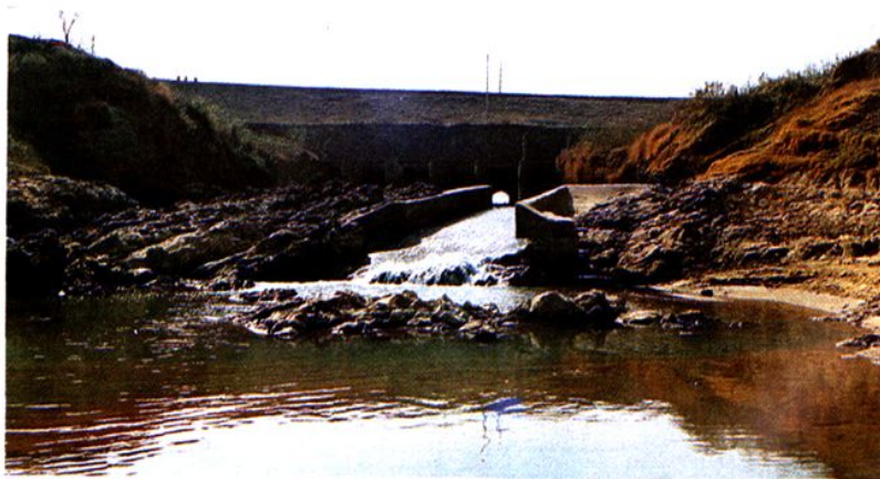
罗旁水闸闸口
