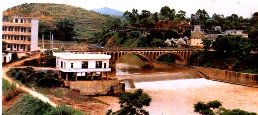
乡镇电站之一的大湾桥头电站(左下)、 职工宿舍(左上)（建于1984年）
