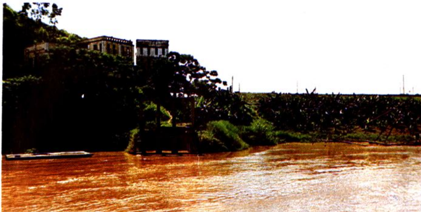
都城鹅公涌 水闸堤 (建于1962年)
