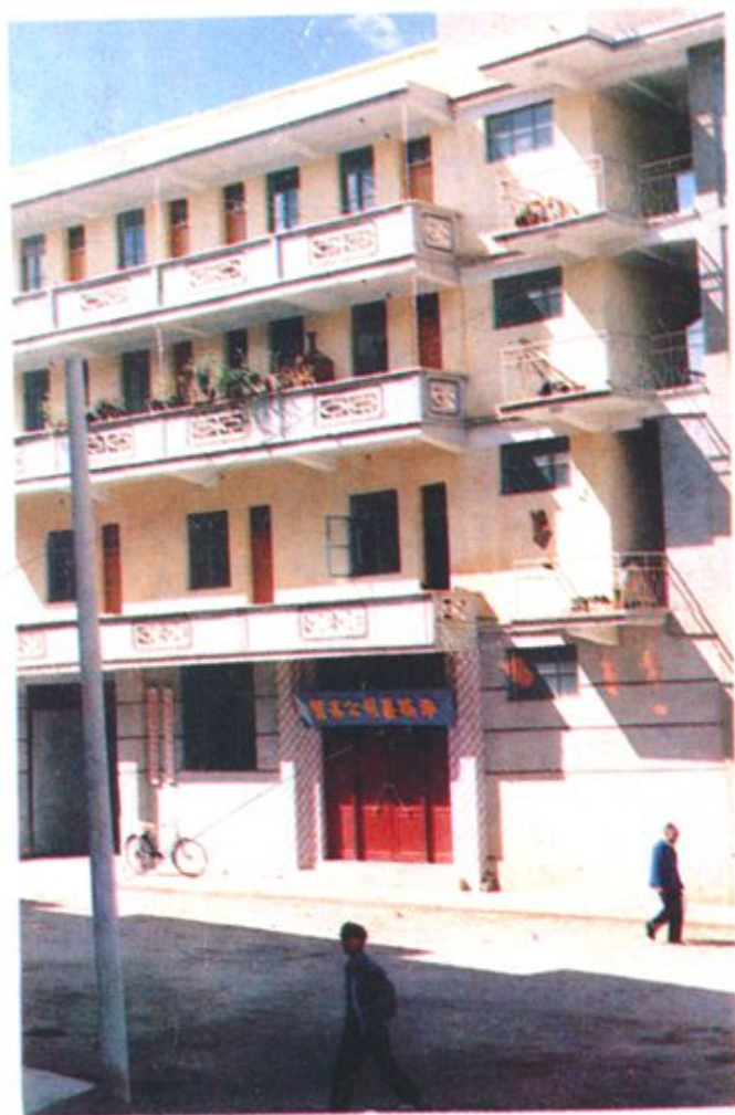
贸易公司营业大楼
