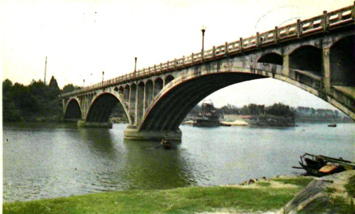
兰溪公路大桥
