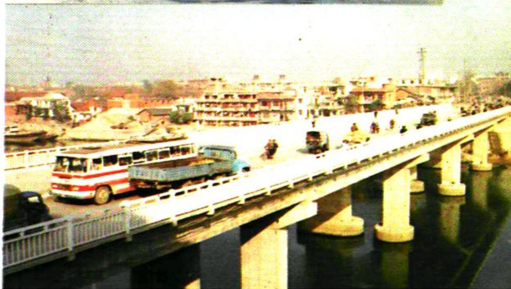
浠水公路大桥
