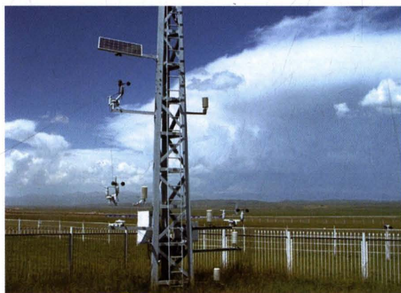
2006年8月建成的牧试站大气边界层梯度观测塔
