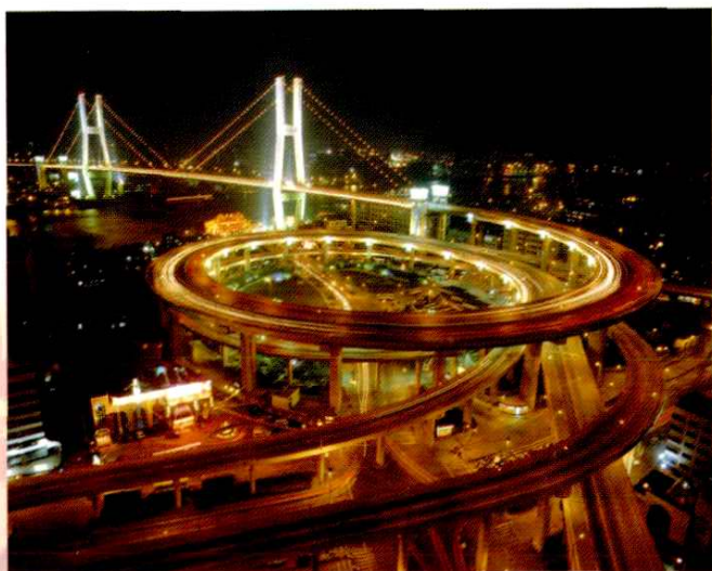
► 南浦大桥为市区第一座跨越黄浦江的大桥，于1990年1月正式动工，总投资8.2亿元，1991年11月建成通车，总长8346米，主桥长846米，列世界同类型桥梁中第三位
