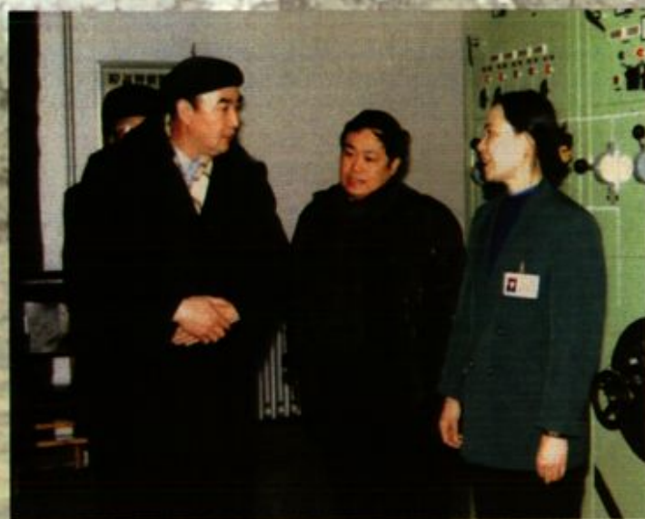
1996年2月，电力工业部副部长赵希正(左)在哈尔滨电业局为亚冬会新建的正阳变电所检查工作
