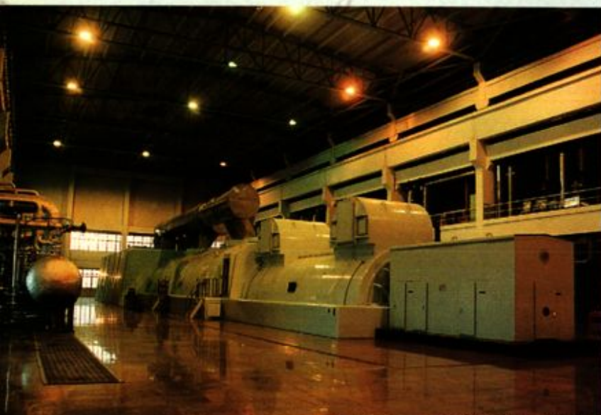
60万千瓦汽轮发电机组及主控制室
