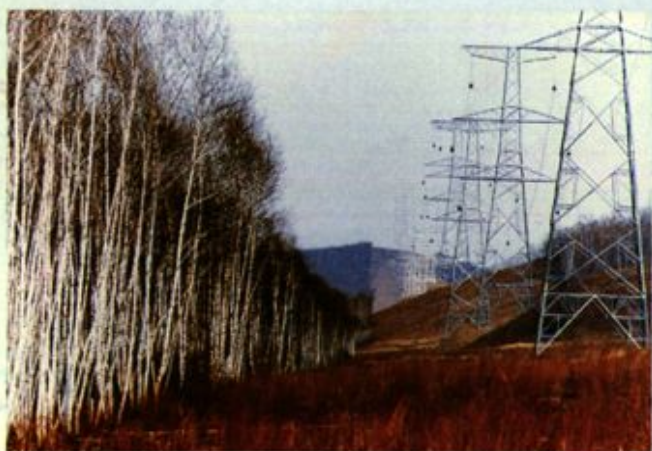
500千伏伊敏—冯屯—大庆输电线路伊冯段同塔 双回穿越大兴安岭
