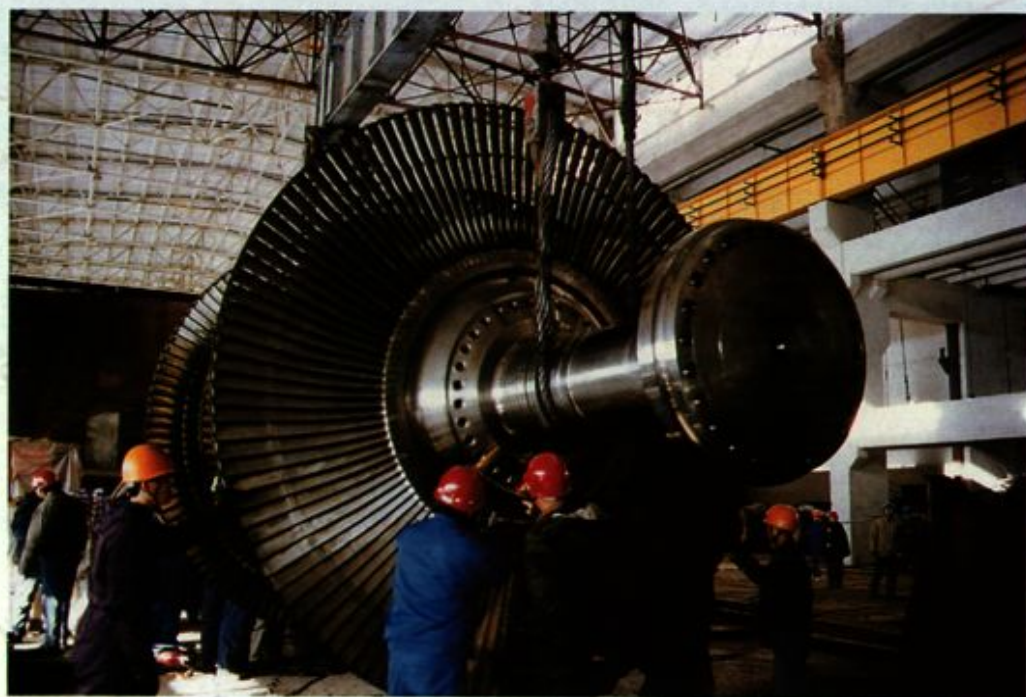
30万千瓦机组汽轮机转子吊装
