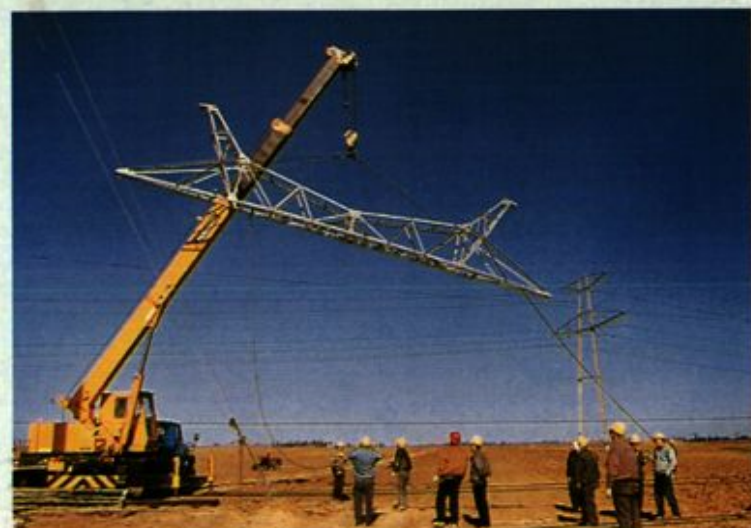
220千伏线路施工
