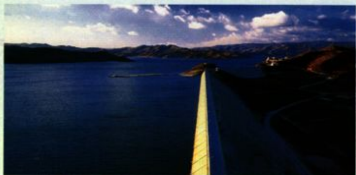
莲花水电站大坝
