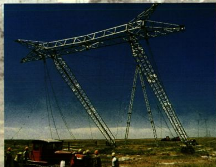
500千伏线路施工现场
