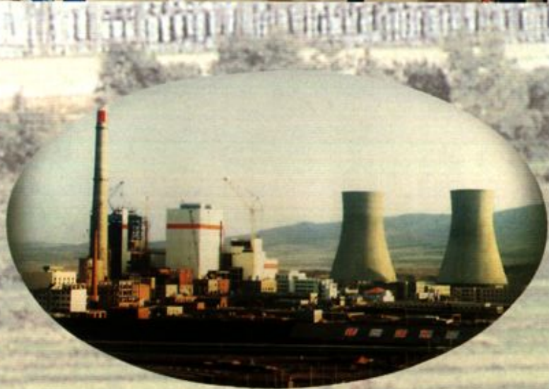
七台河第一发电有限公司2台35 万千瓦机组建设
