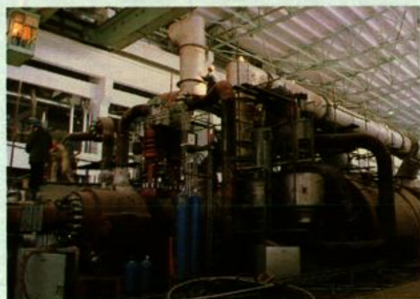
哈尔滨第三发电有限公司首台60万千瓦机组 安装
