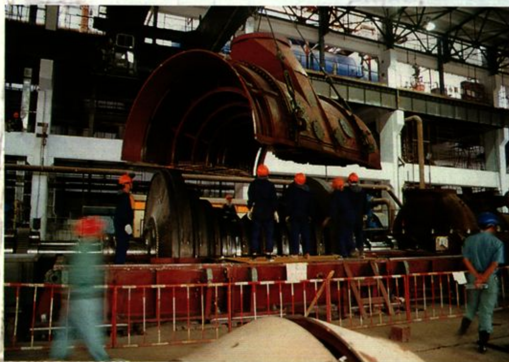
35万千瓦机组汽轮机扣大盖
