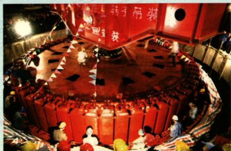
莲花水电站13.75万千瓦水轮机转子吊装
