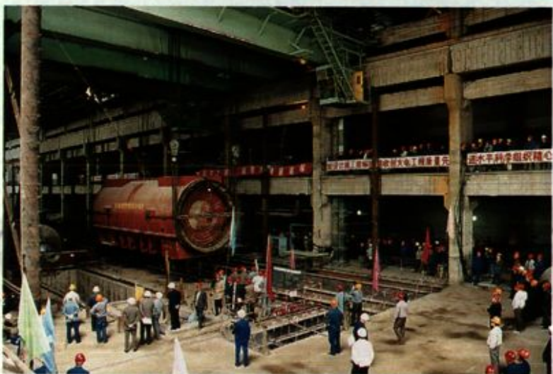
哈尔滨第三发电有限公司2台 (3、4号)60万千瓦机组建设过程中定 子互换
