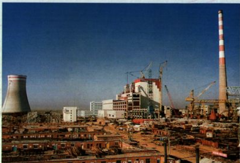
鹤岗发电有限公司2台30万千瓦 机组建设
