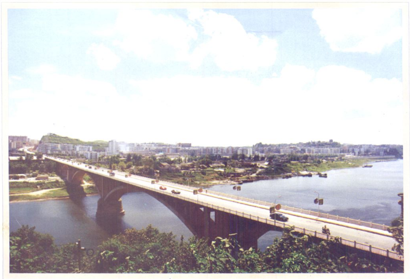
1994年建成并投入使用的潼南涪江大桥成为连接重庆潼南工业园区南区和北区的重要交通枢纽。
