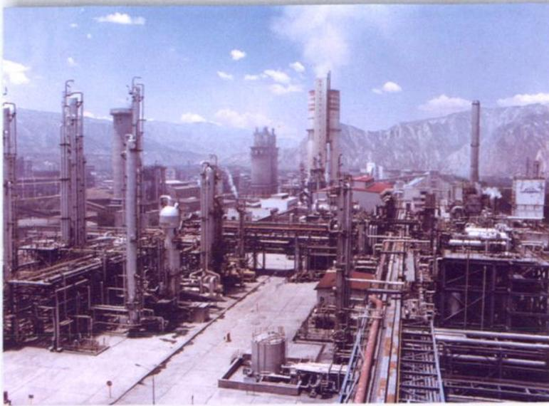
引进30万吨合成氨、50万吨尿素装置
