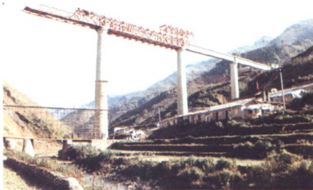
ZQJ-Z32/56 移动支架造桥机在宁夏灵武铁路黄河特大桥(左)和南昆铁路打埂大桥(右)应用。此项技术获中国铁道建筑总公司科技进步一等奖、国家发明四等奖。
