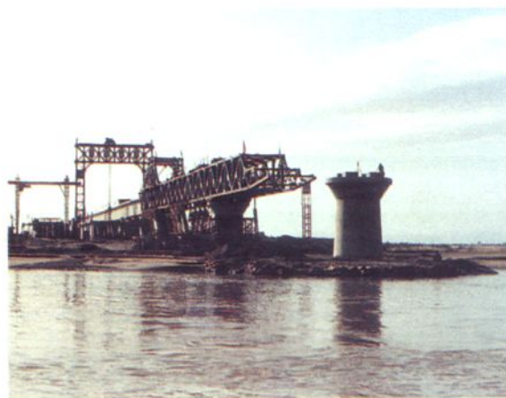
ZQJ-Z32/56 移动支架造桥机在宁夏灵武铁路黄河特大桥(左)和南昆铁路打埂大桥(右)应用。此项技术获中国铁道建筑总公司科技进步一等奖、国家发明四等奖。
