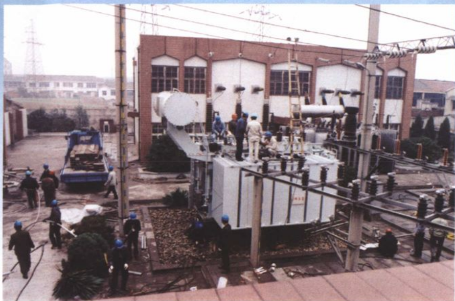
1990年8月， 丹阳市110千伏北 门变电所移址工 程施工现场
