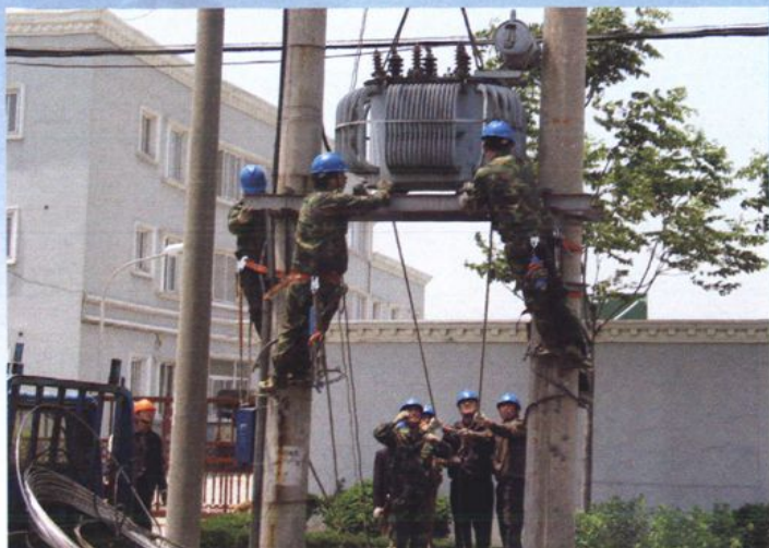
2000年3月，丹阳市开发区供电所职工在进行农网改造施工
