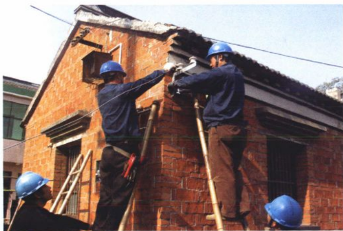
2000年5月，丹阳市河阳供电所职工在进行农网改造施工
