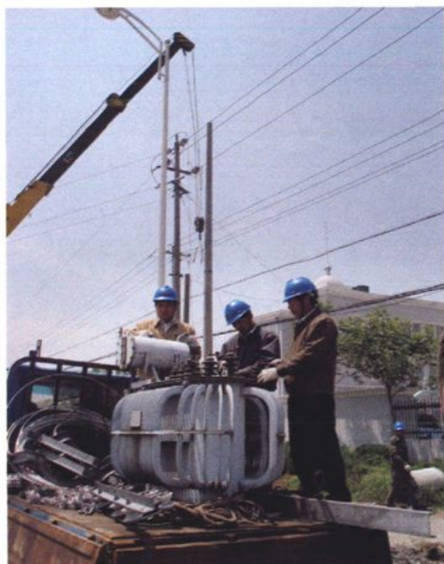
2000年4月，丹阳市后巷供电所职工在进行农网改造施工
