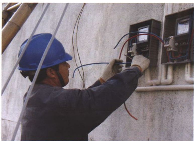
2001年5月，丹阳市导墅供电所职工在进行农网改造施工
