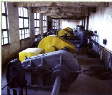
溢洪道闸门控制室
