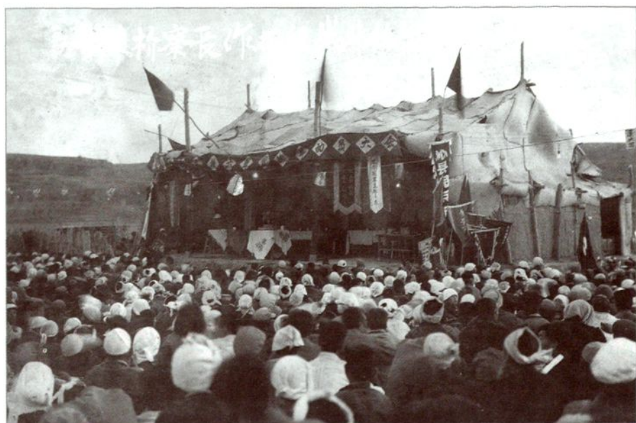
1959年6月15日，晋东南地区检察院检察长、关河水库工程指挥部党委书记陈光明作保坝度汛的战斗动员
