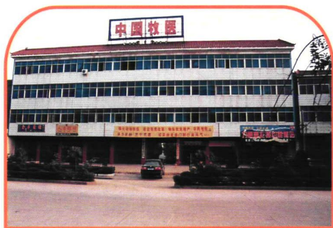
新建的保安动物防检站大楼
