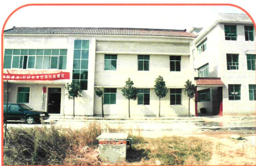
殷祖防检站办公及宿舍楼
