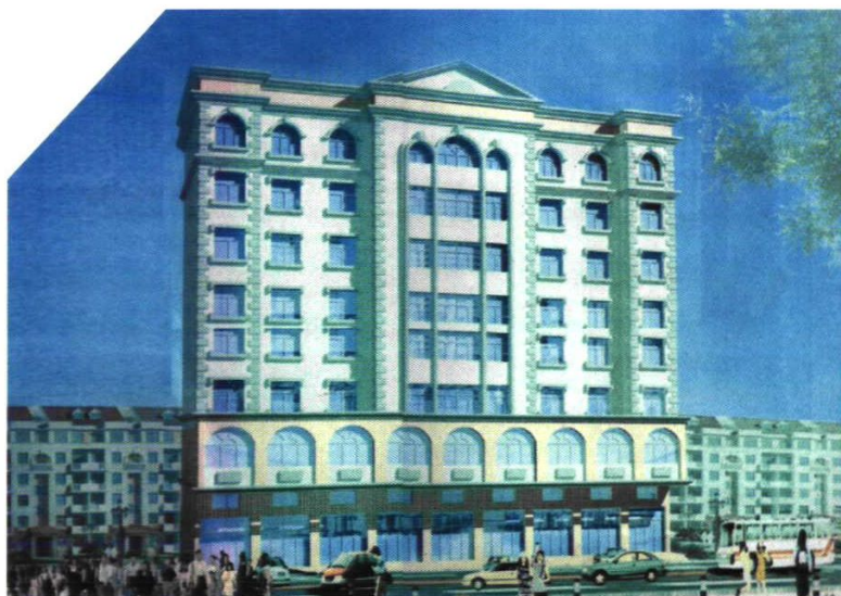
大冶市畜牧局新建的综合楼
