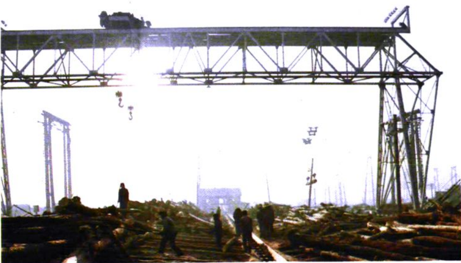
贮木场龙门吊卸车
