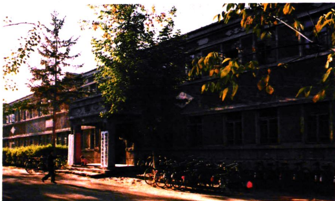
林业局办公楼
