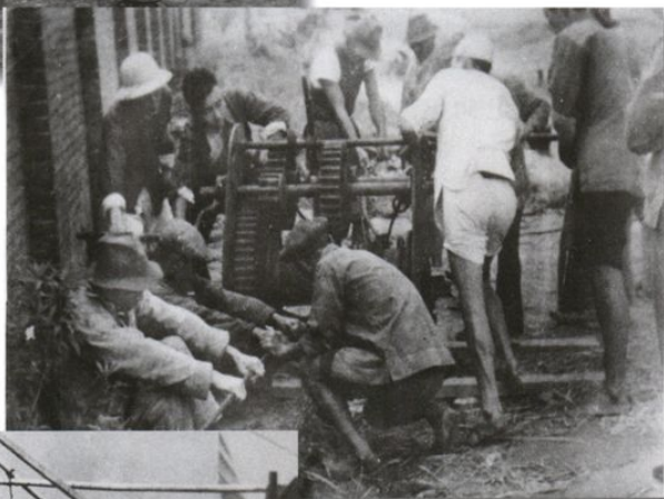
▶ 绞车扳正沉船主要依靠人力和手工完成。
