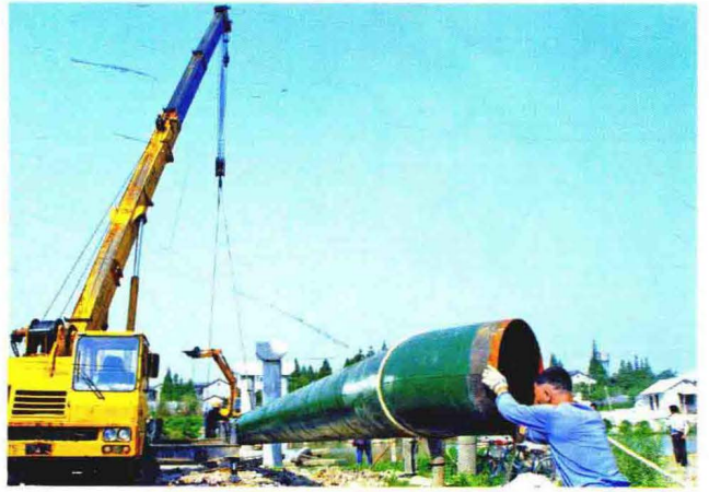
污水纳管工程
