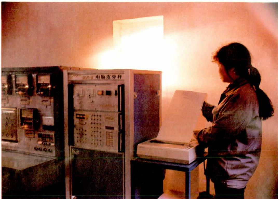
BSM-II型电脑皮带秤控制系统
