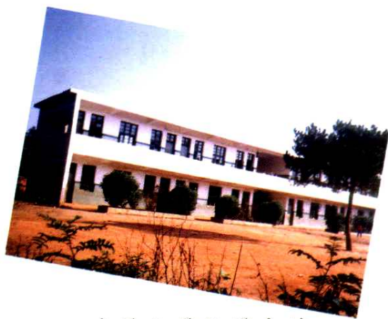
店前小学教学大楼
