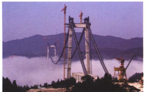
三家馆乡鸭坪特大桥
