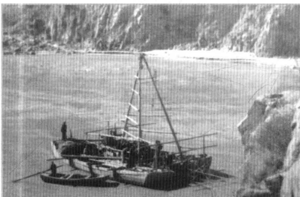
2. 在激流的河水中施测神门河的水深，以便决定穿河平硐的高程
