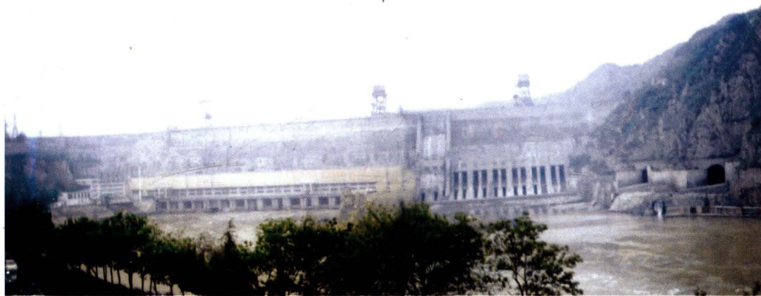
3. 增、扩建后三门峡大坝左岸的两个输沙洞（右侧）
