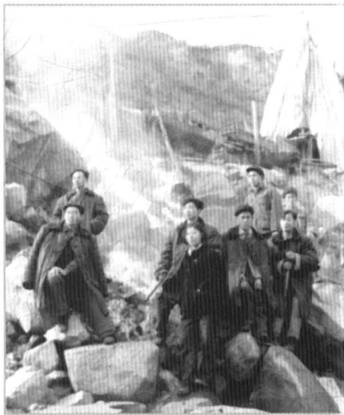
4. 勘探队员们正在七里沟进行74号钻孔的抽水试验
