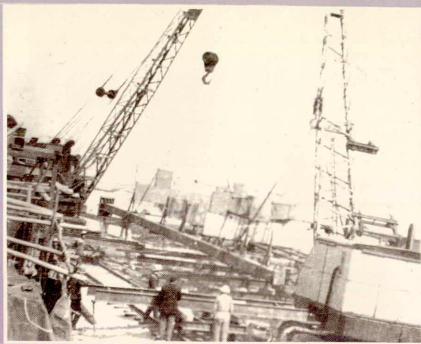
在龙凤热电厂工程吊装中，为了解决吊装机械的不足，起重工人和技术人员研究创造了三套起重一次吊装法，图为使用这些吊装法正在进行吊装。
