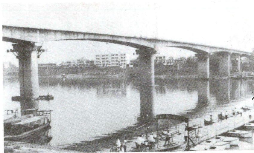
在建的鹰潭夏埠大桥
